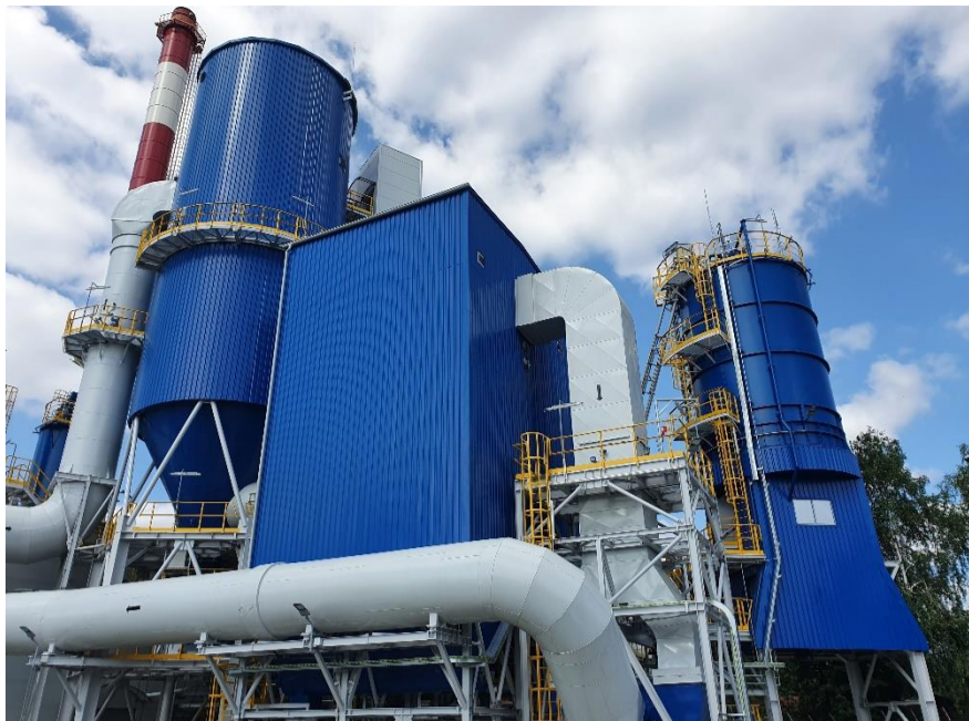
Widok absorbera i filtra workowego wraz z kanałem spalin wylotowych.
