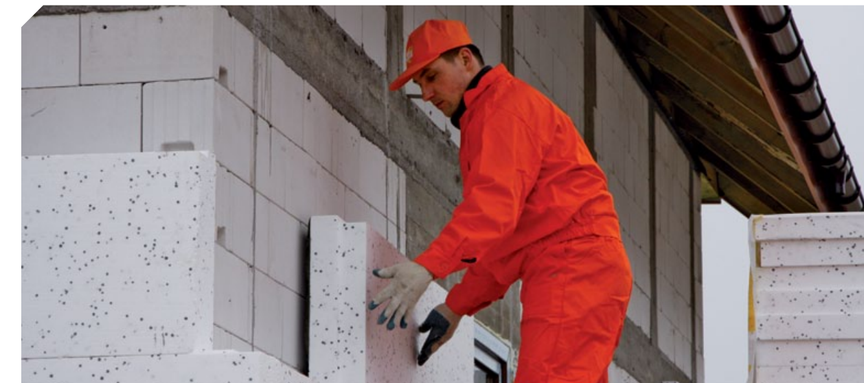
Aby odnieść zamierzony efekt, działania termomodernizacyjne trzeba poprzedzić dokładną analizą inżynierską.
