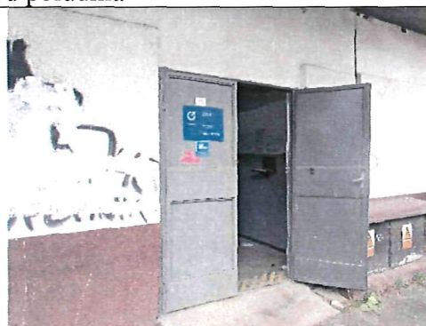
Wejście do budynku
