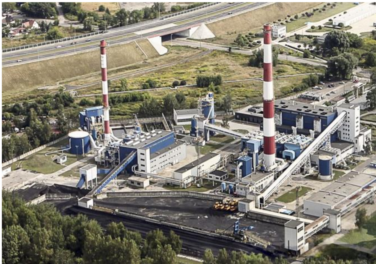
Rysunek 1. Przedsiębiorstwo Energetyki Ciepłej – Gliwice Sp. z o.o. (Ciepłownia)
